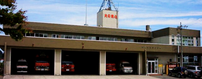
● 消防本部・網走消防署 ※R9年度新庁舎完成予定
