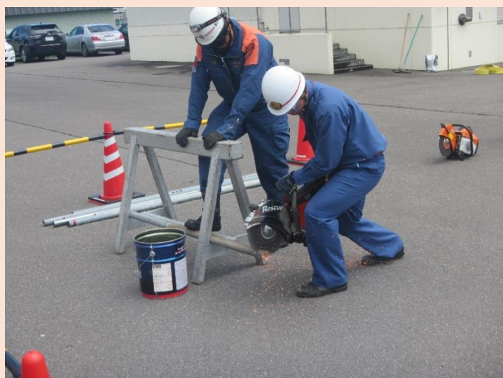
エンジンカッターで鋼管を切断
