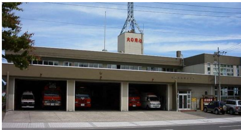
〈消防本部庁舎〉
