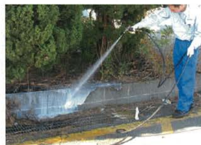
専門業者による液剤の高圧散布
